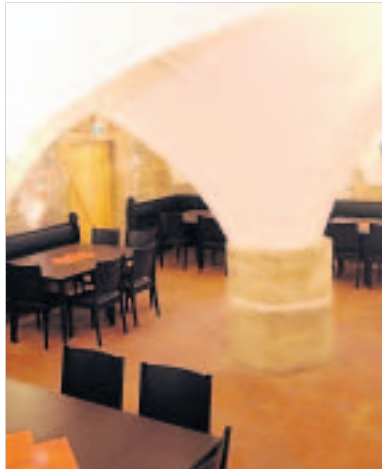
Der Weinkeller im Schloss Klipphausen mit imposanten Kreuzgratgewölben. Foto: Hübschmann
